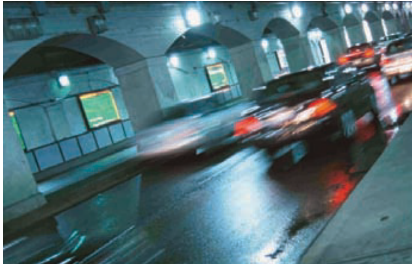
FIGURA 1 De difusa a especular a) El agua sobre la superficie del camino convierte la reflexión difusa, que había antes de la lluvia, en reflexión especular. b) Así, en lugar de ver el camino, el conductor sólo percibe las imágenes reflejadas de luces y edificios.
