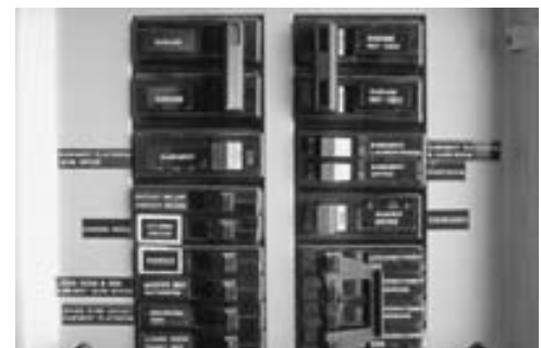
▲ FIGURA 4.21 Disyuntores de circuito a) Diagrama de un dispositivo térmico de desconexión. Al aumentar la corriente y el calor de joule, el elemento se dobla hasta que se abre el circuito para algún valor prefijado de la corriente. También existen dispositivos de desconexión que utilizan principios magnéticos. b) Un conjunto de disyuntores domésticos comunes.
